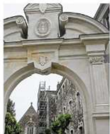
Le porche qui encadre l'entrée du monastère, rue Vauvert, date du milieu du XIX e siècle. Il vient d'être restauré par les tailleurs de pierre. Photo: CD-LAUREN COMBET
